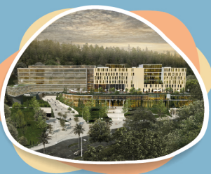
CAMPUS UDLAPARK 2 EN CONSTRUCCIÓN
